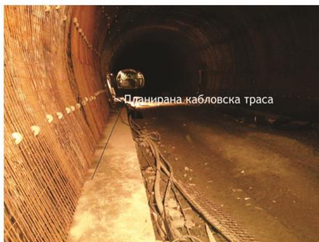
SLIKA 3 UNUTRAŠNOST TUNELA “MANAJLE” U FAZI IZVOĐENJA RADOVA
